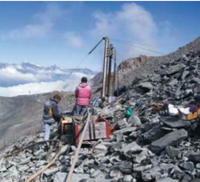
Bohrarbeiten in der gefrorenen Schutthalde von Les Attelas im Herbst 2008.
